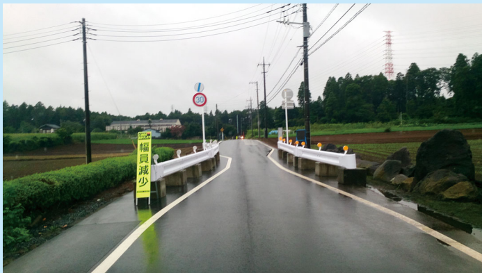
写真1 事故現場付近に設置された狭くと30キロ規制表示
