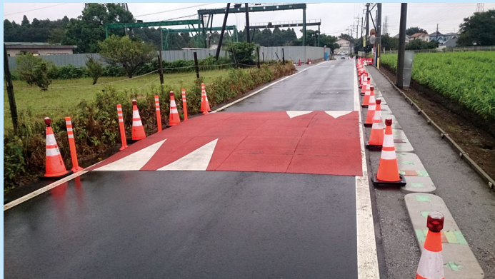
写真2 事故現場付近に設置されたハンプ(段差)
